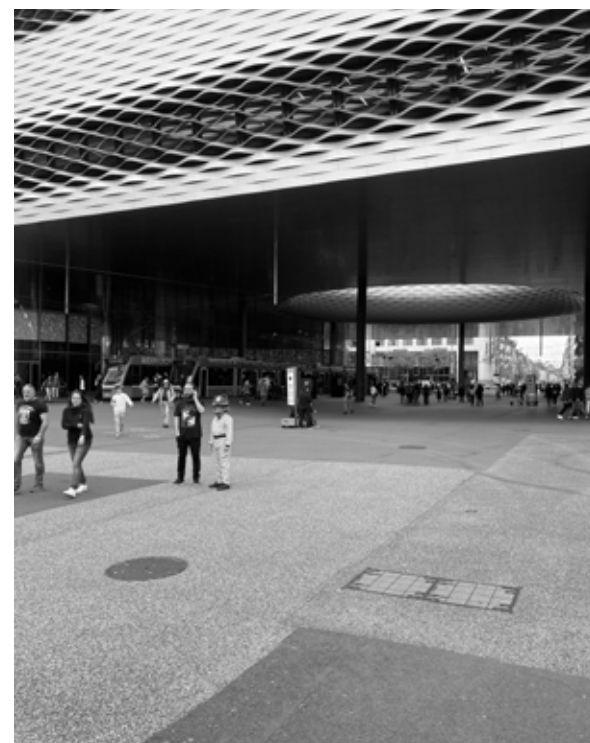
Basilea, Event Halle alla Messe (2010-2013), arch. Herzog de Meuron, Basilea, ing. zpf, Basilea. Committenza: HCH Group. 8 Foto Jacques Gubler
